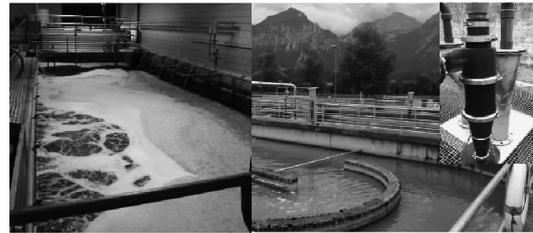
图 12 Strass 厂侧流与主流厌氧氨氧化系统
