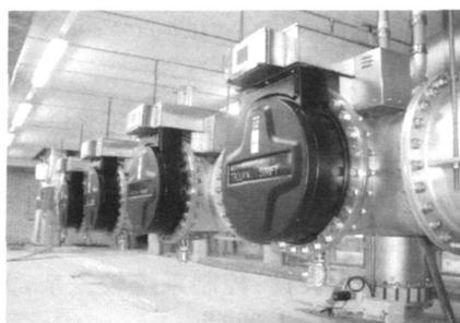
图6 荷兰 PWN 水厂紫外线消毒设备
