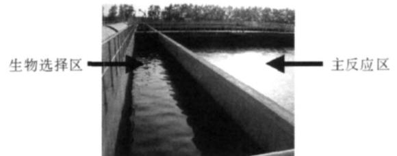
图 3 CAST 生物反应池
