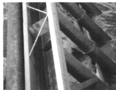
图 5 滗水器主管和支管连接及排水图
